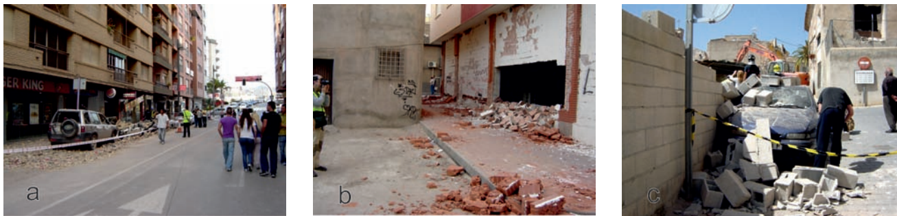
Figura 1. En el terremoto de Lorca de 2011, la caída de elementos no estructurales como cornisas, paños de fachadas o muros causó la mayoría de los daños materiales y víctimas. Este terremoto es un ejemplo de los daños que puede sufrir una ciudad española ante un evento sísmico de moderada magnitud.
