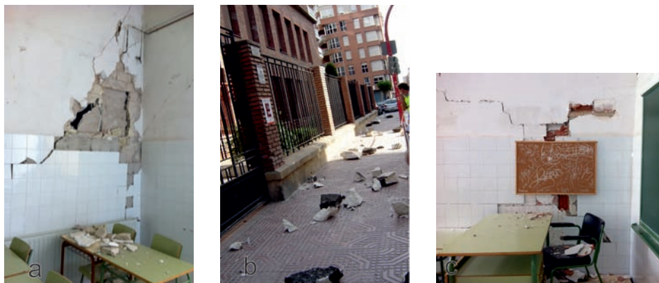
Figura 6. Principales daños observados en los centros educativos de Lorca en el terremoto de 2011: caída de paredes y rotura de alicatados en el interior y caída de ornamentación en el exterior. Durante un terremoto caen objetos pesados que pueden herir a las personas que están intentando salir de los edificios corriendo. Por esto, el mejor refugio durante un seísmo está debajo de mesas y pupitres.
