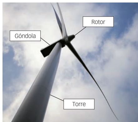
Figura 1. Componentes principales del aerogenerador.
